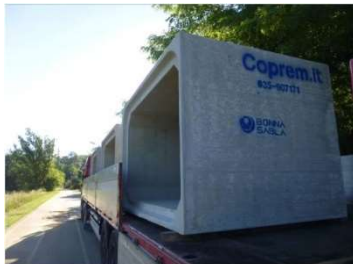
Les cadres Coprem Bonna Sabla sur le plateau avant leur manutention
